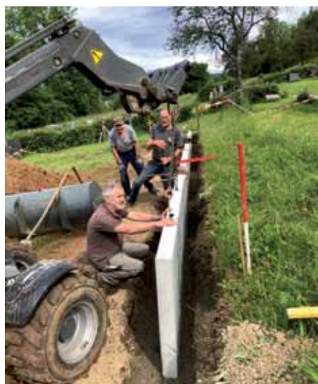
Die Platten für die Mauer werden gesetzt
